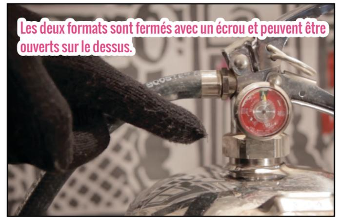
Les deux formats sont fermés avec un écrou et peuvent être ouverts sur le dessus.
